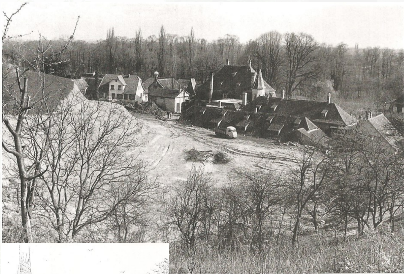
Au début des travaux par les pères spiritains. On distingue la chapelle Sainte-Marie Auxiliatrice masquée en partie par la salle de billard encore debout et qui servait dans un premier temps de chapelle à la congrégation.
