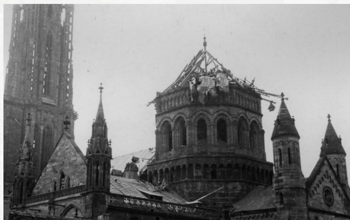
La tour Klotz endommagée par le bombardement anglo-américain du 11 août 1944.
