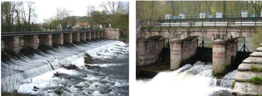
Barrage de la Bruche construit par Vauban au 17<sup>ème</sup> siècle. Cette construction est au cœur d'un vaste dispositif mis en place pour accéder aux carrières d'extraction de grès de Soultz et pour acheminer par voie d'eau les matériaux en direction de Strasbourg
